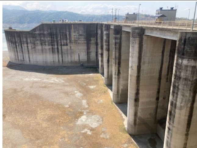
Larawan 22: Mga spillway gate mula sa upstream 2
