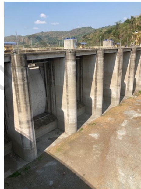
Larawan 21: Mga spillway gate mula sa upstream 1
