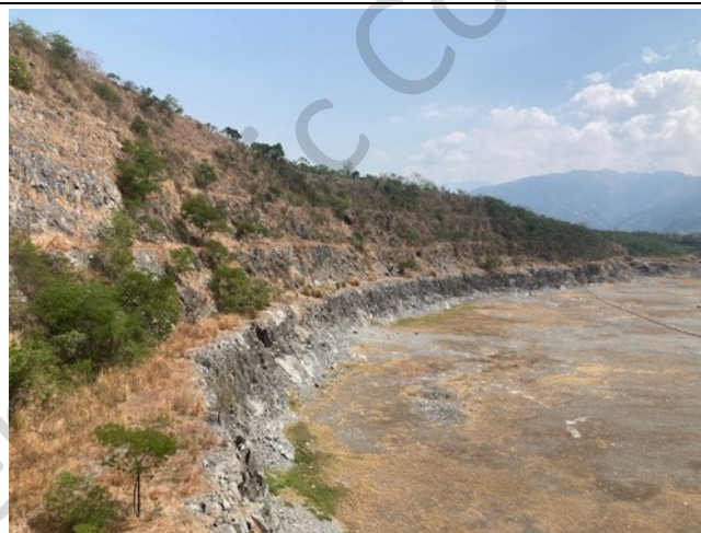
Larawan 11: Mga hukay na baitang sa itaas ng spillway, na may mga materyales na ginamit para sa rockfill ng dam
