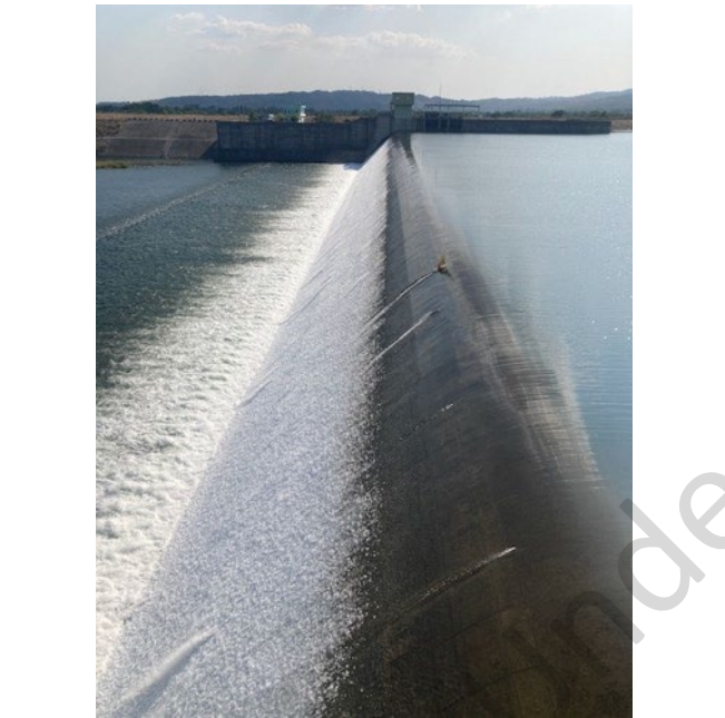
Larawan 82: Weir ng re-regulating pond na umaagos sa pagitan ng mga panahon ng irigasyon
