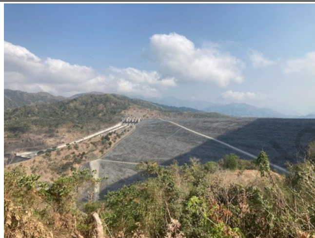
Larawan 28: Dam na may spillway na nakikita mula sa surge shaft
