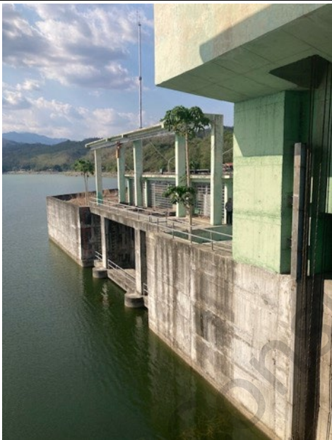
Larawan 62: Mga gate ng intake para sa kanal ng irigasyon sa kaliwang pampang (naka-sara)
