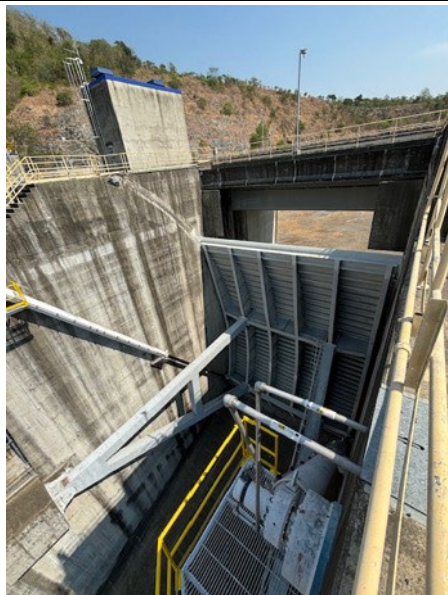
Larawan 25: Spillway gate mula sa downstream
