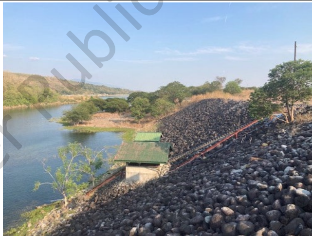
Larawan 53: Mga water pump na nagbibigay ng tubig pambahay sa kampo at mga opisina ng SRPC
